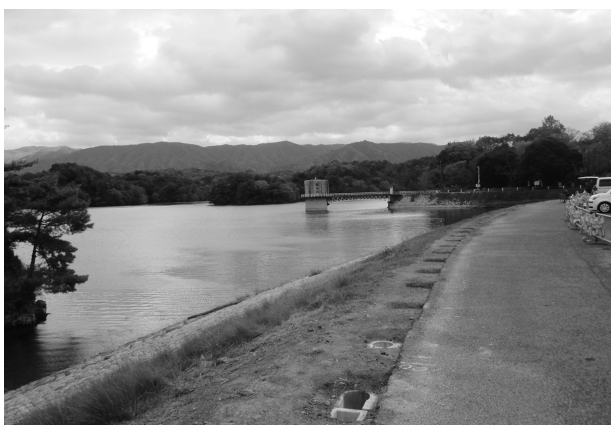
堤体右岸側から取水等を望む
